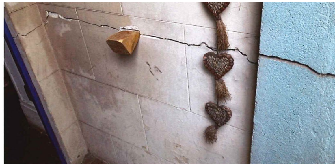
Désordres intérieurs au RDC haut mettant en évidence un affaissement du plancher vers façade avant
