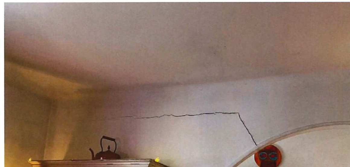
Désordres intérieurs au RDC haut mettant en évidence un affaissement du plancher vers façade avant
