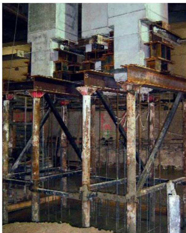
Photo n° 11 : reprise en sous-œuvre par micropieux
