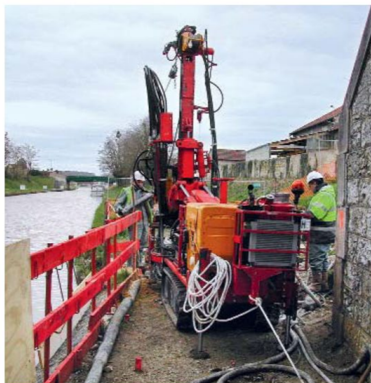
Photo n° 12 : sondeuse pour micropieux
