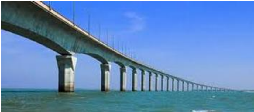
Le Pont de l' Ile-de-Ré , BOUYGUES, 1987-88
