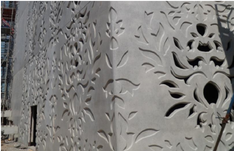
Façade d'immeuble en BAP, CALCIA
