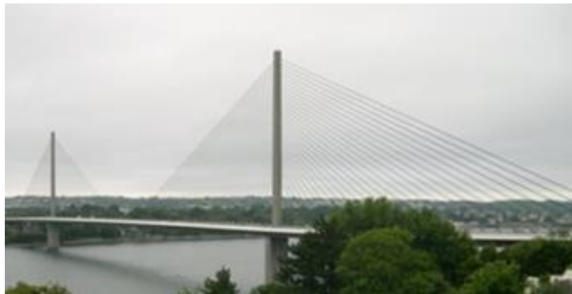
Le Pont de l' Iroise , RAZEL, 1992-94
